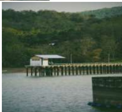
Gambar 1. Bendungan Pengga Lombok Tengah
